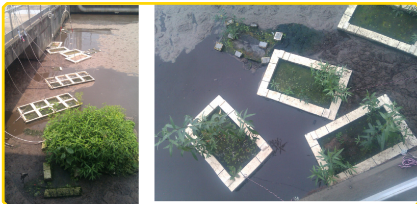
Fig. 1. Celle a combustibile microbiche in sperimentazione in una vasca di depurazione dell'impianto Milano-Nosedo.
