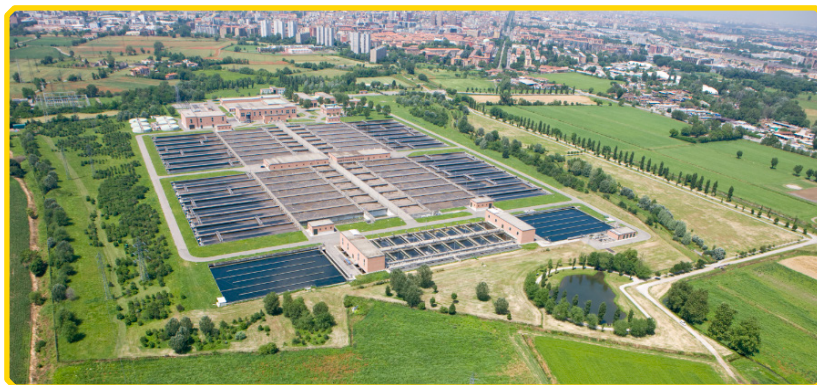
Fig. 2. L'impianto di depurazione Milano-Nosedo. Sito a sud di Milano, al centro del Parco della Vettabbia (Valle dei Monaci).
